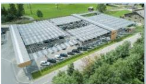
Solarfaltdach über dem Parkplatz der Kronbergbahn, AI
