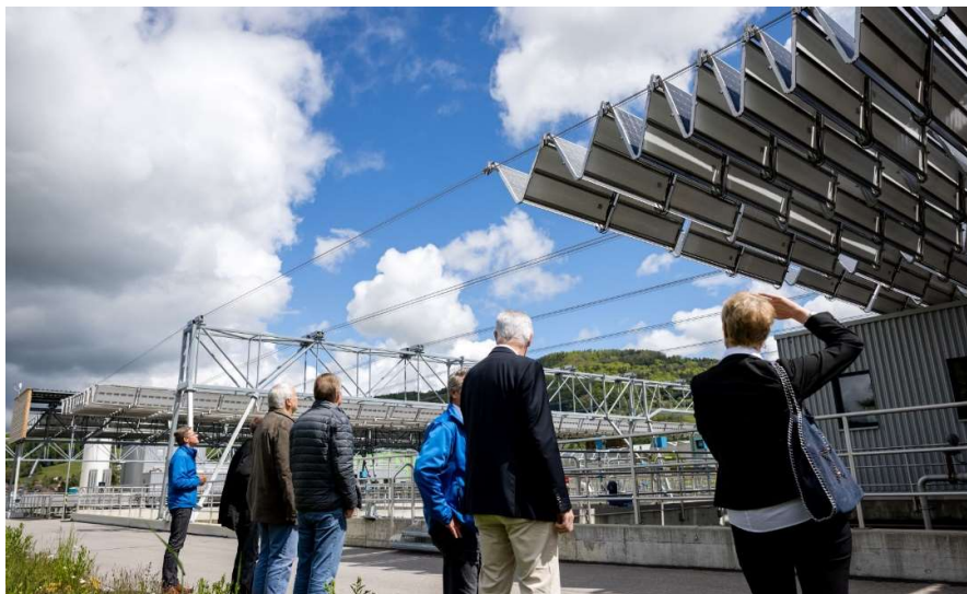
Bild: Solarfaltdach fährt aus über der Kläranlage Reinach, Aargau/Schweiz
