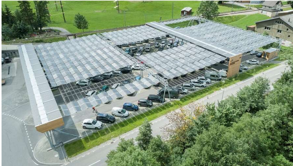
Bild: Solarfaltdach über dem Parkplatz der Luftseilbahn Kronberg, Appenzell/Schweiz
